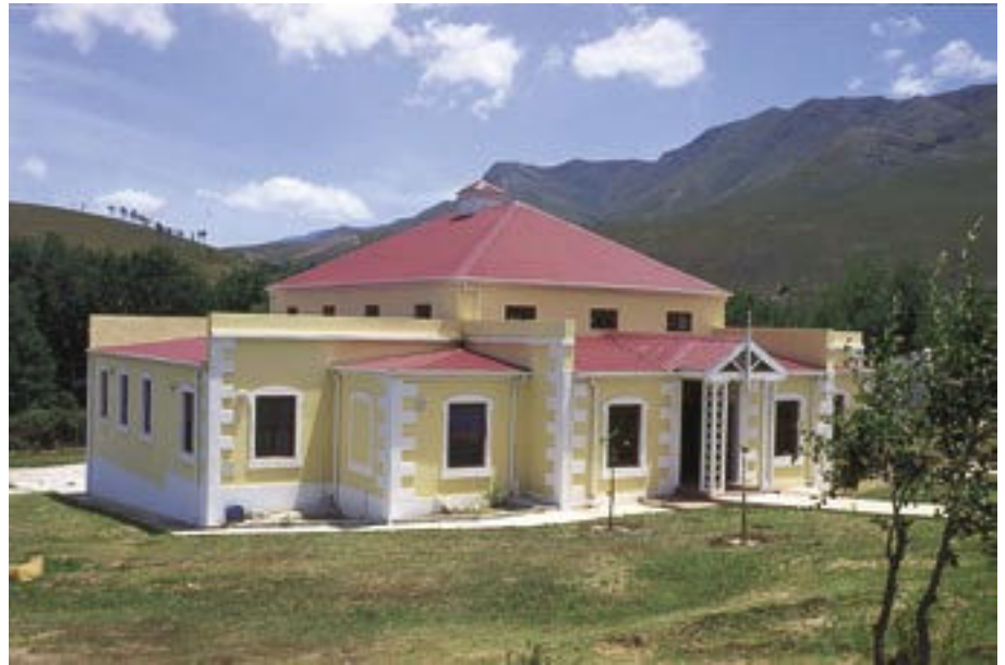
Die Missionsstation in Genadendal wurde 1793 gegründet. Die Bauweise vermittelt heute noch einen Eindruck vom Leben vor 150 Jahren am Kap. (Foto: Library Service Western Cape)
